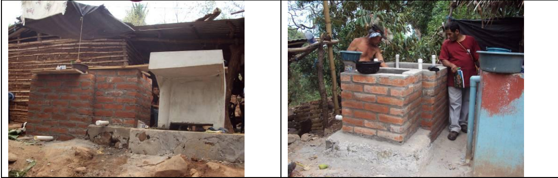
Se muestran dos biofiltros que ya esta construidos y listo para entrar en funcionamiento por la comunidad.
