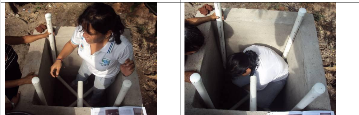
Llenado de un biofiltro, en estas dos fotos se muestra a la beneficiaria Señora Estela Monges como se debe colocar la primera capa de piedra volcánica de la más gruesa en el fondo y como dejar la salida del agua descubierta para que no se obstruya en un futuro.
